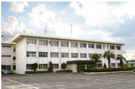
長崎県消防学校
